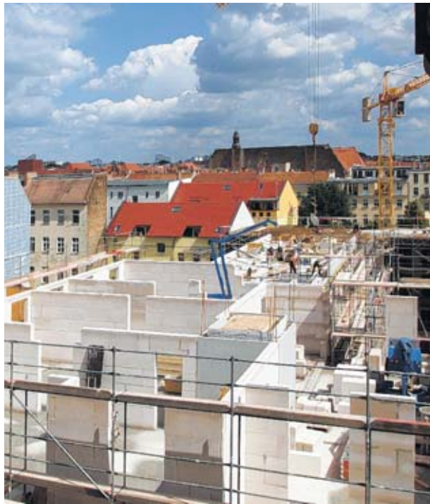
Blick auf die Baustelle des neuen Wohnquartiers Wingärten. Bis zum kommenden Frühjahr entstehen hier 45 Wohnungen in grüner Lage neu.
